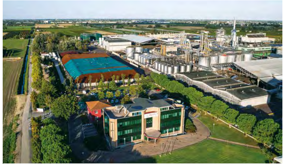
Il sito faentino di Caviro Extra che riceverà sostanziali miglioramenti riguardo a tecnologie, sostenibilità e sicurezza
